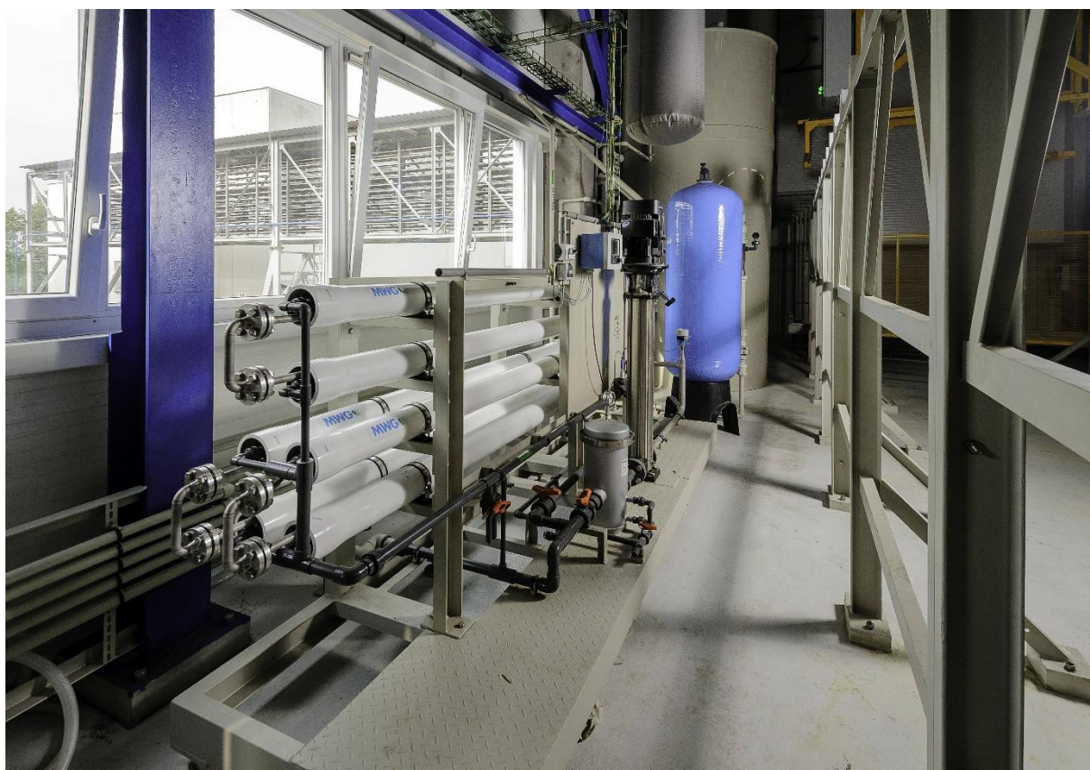
Obrázek 4 Reverzní osmóza pro výrobu demivody
