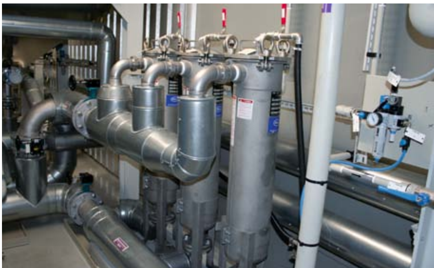
Ruční klapky VZAV s převodkami pro regulaci, kulové kohouty Typ 707 a úpravná jednotka Festo.
