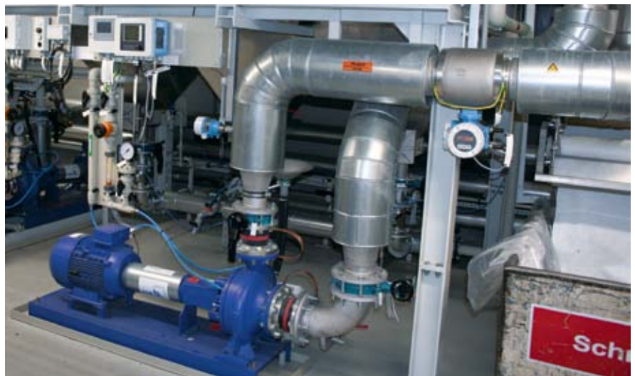
Ruční klapky VZAV a kompenzátory Garlok na fosfátovací lázni.
