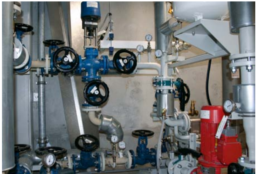
Třífázový regulační ventil, sedlové uzavírací ventily Typ 471 a klapky VZAV s ruční pákou.
